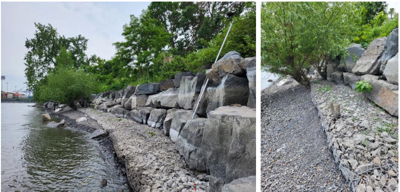
Figure 13 Tronçon 1024 du parc Promenade-Bellerive stabilisé par des gabions en bas de talus et des gros blocs de roches alignés au-dessus.
