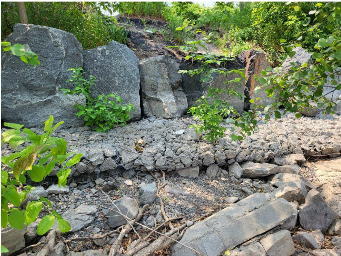
Figure 17 Tronçon 1028 du parc Promenade-Bellerive stabilisé par des gabions en bas de talus et des gros blocs de roches alignés au-dessus.
