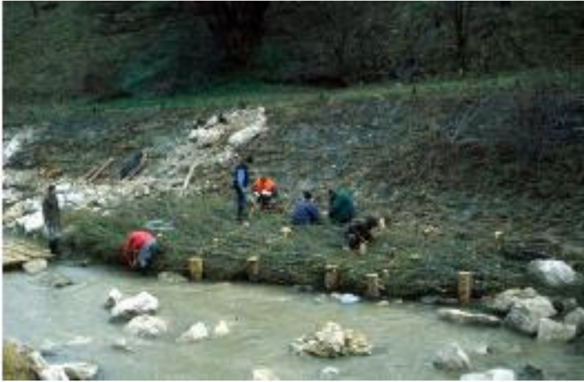
Photographie d'une construction de grilles de branches, région du Tyrol, Autriche. Tiré de Florineth (2007).
