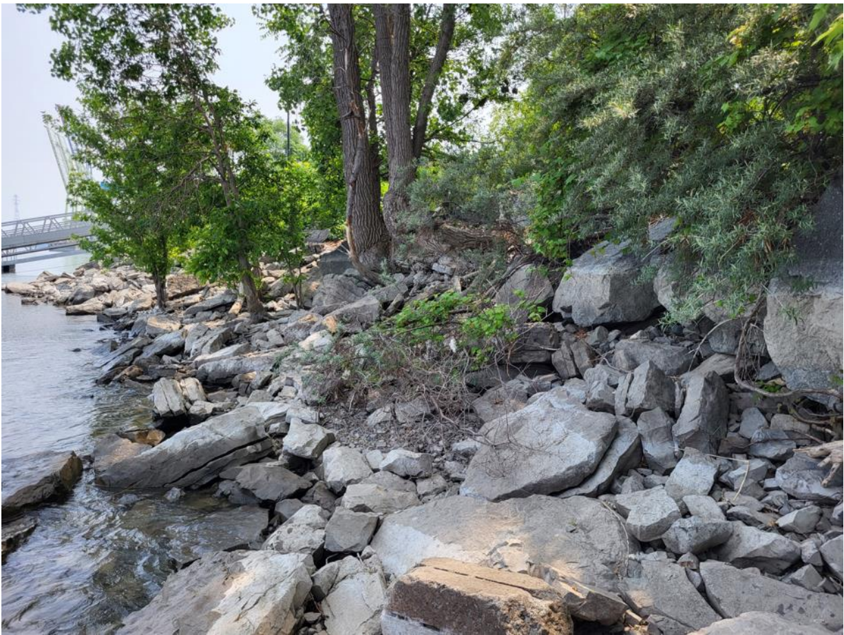
Figure 15 Tronçon 1027 du parc Promenade-Bellerive stabilisé par des gros blocs de roches alignés au-dessus du pied de talus.
